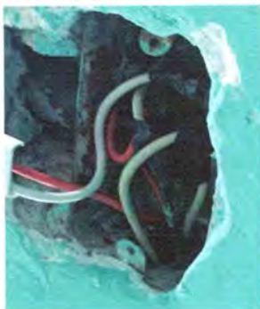
Foto 3: Cambio de sistema eléctrico por deterioro y mala conexión.
