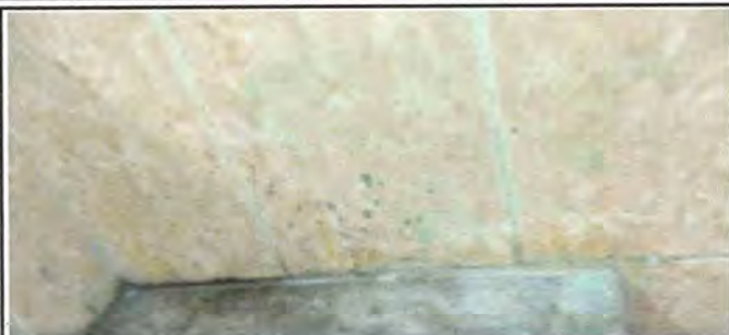
Foto 1: Reparación de repello y cernido de paredes.
