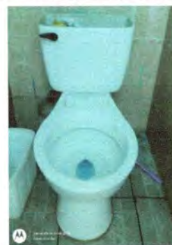
Foto 6: Cambio de baños por deterioro.
