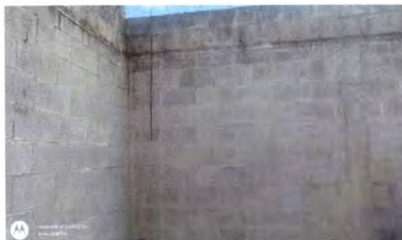
Foto 4: Reparación de repello y cernido de paredes.
