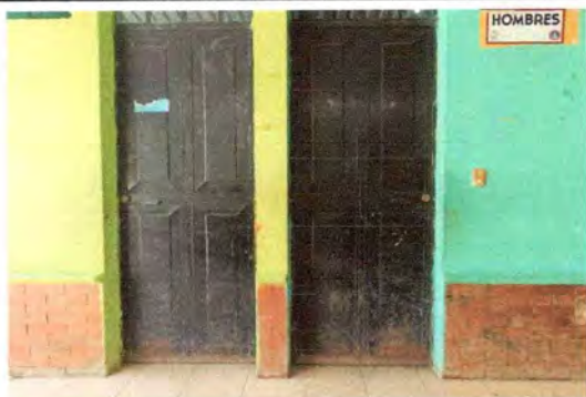
Foto 3: Cambio de puertas por deterioro.
