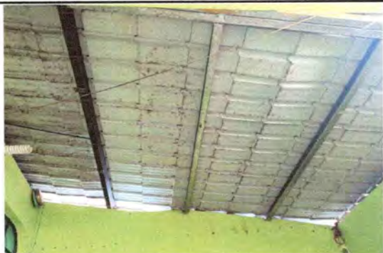
Foto 1: Cambio de techado por deterioro.
