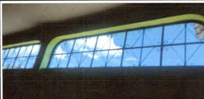
Foto 4: Colocación de balcones por seguridad.
